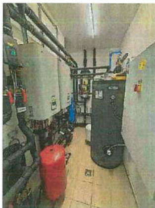
levegő-víz hőszivattyúk beltéri egysége és HMV indirekt tartály
