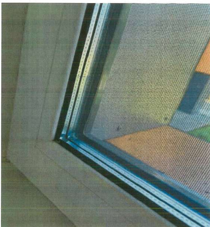
Jellemző ablak – 3 rétegű hőszigetelt üvegezéssel
