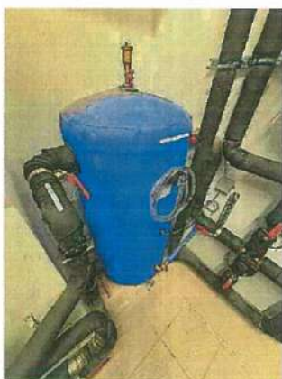
levegő-víz hőszivattyúk beltéri egysége és HMV indirekt tartály
