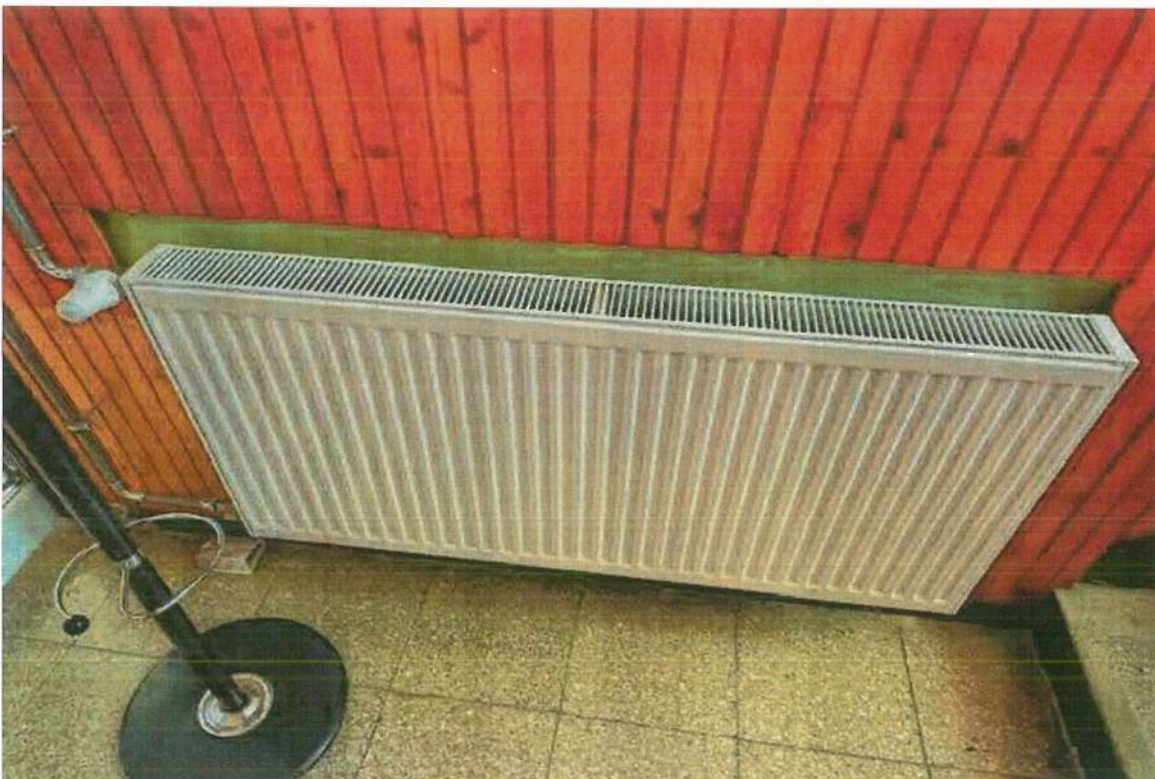
Lapradiátor – termosztatikus radiátorszeleppel
