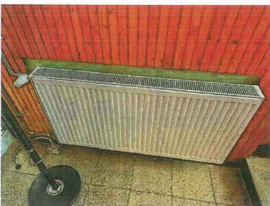
termosztatikus szeleppel szerelt lapradiátor
