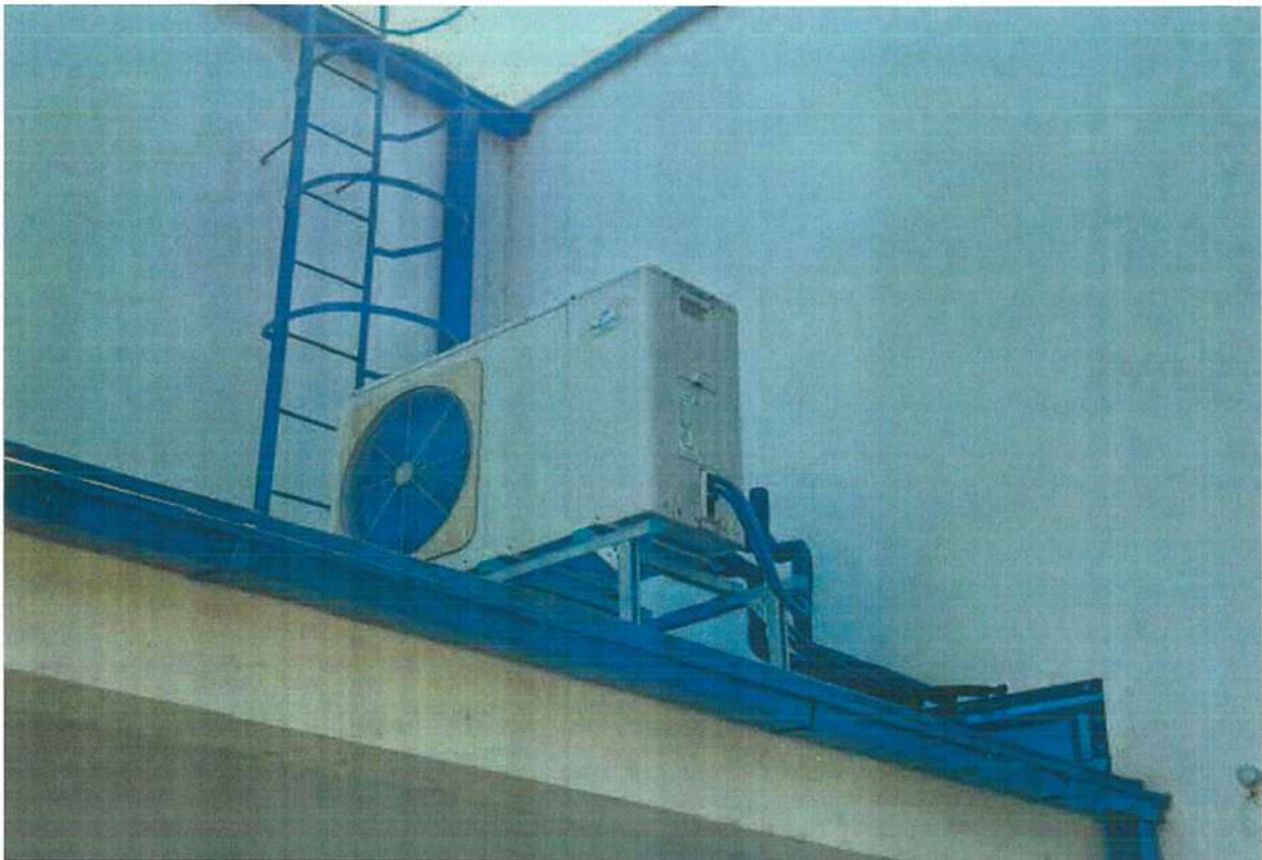
Levegő-víz hőszivattyú
