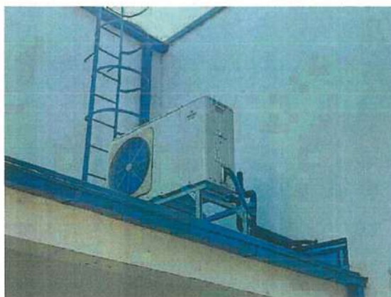
levegő-víz hőszivattyú
