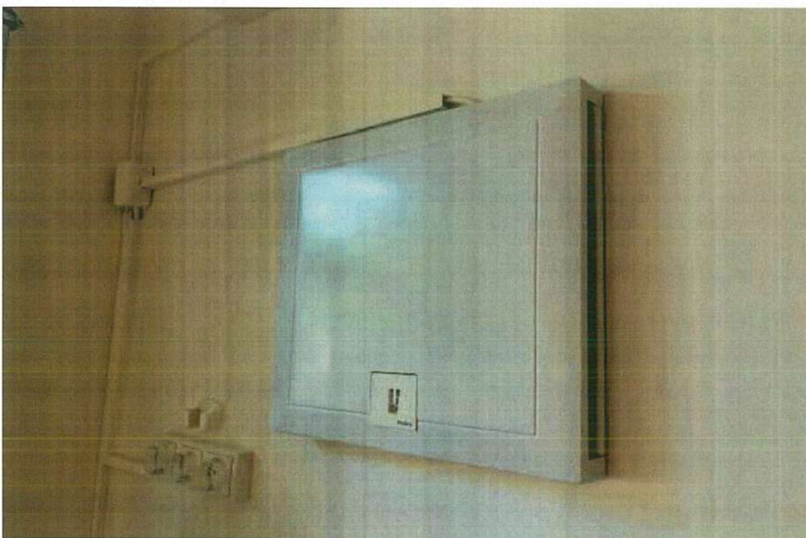
Egyhelyiséges hővisszanyerős szellőző
