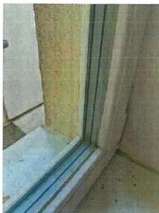
jellemző műanyag nyílászáró
