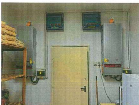
napelemes rendszerhez tartozó inverter
