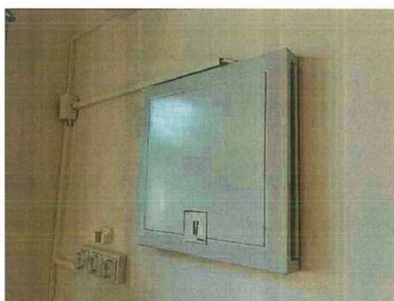
egyhelyiséges hővisszanyerős szellőző
