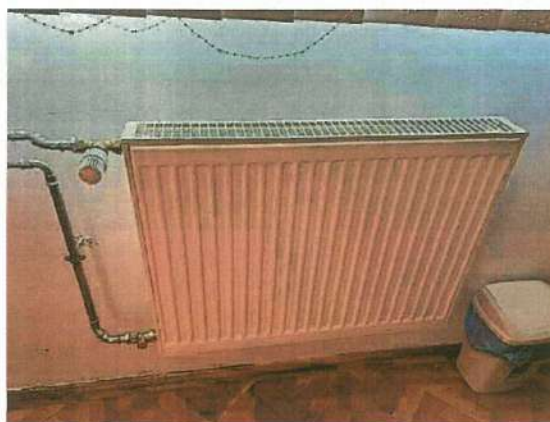
lapradiátor - termosztatikus szeleppel
