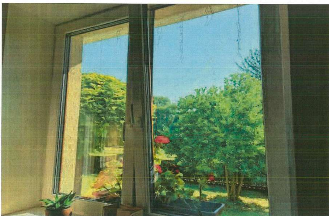
Jellemző ablak – 3 rétegű hőszigetelt üvegezéssel
