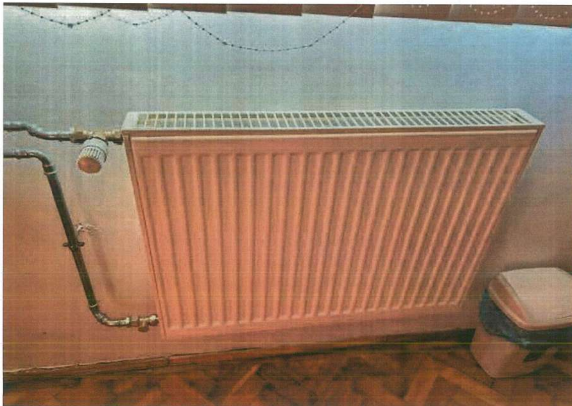
Lapradiátor – termosztatikus radiátorszeleppel
